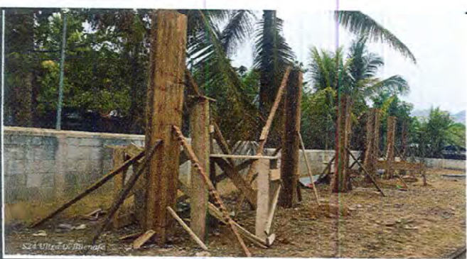
Foto 5: Se observar la fundición de columnas que servirán como base de la ampliación del corredor.
