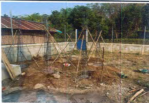
Foto 3: Se puede observar la instalación de las columnas que servirán para base de la galera en la cuál se instalarán los tinacos o depósitos de agua.
