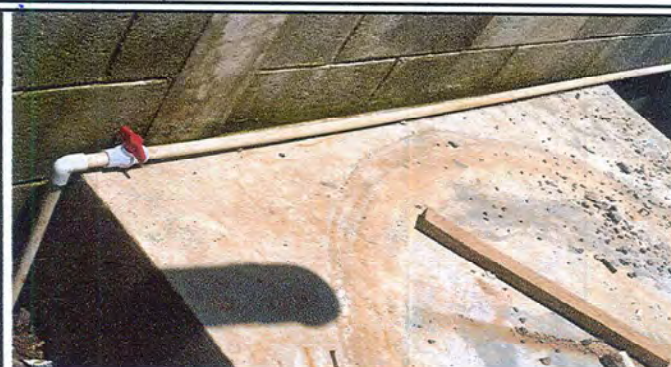
Foto 2: Se puede observar la instalación del entubado que servirá para distribuir el agua de los depósitos de agua a las respectivas llaves de chorro.
