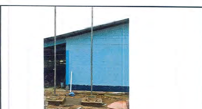
Foto 6: Se puede observar que se procede a pintar el zocalo de las paredes de la escuela.
