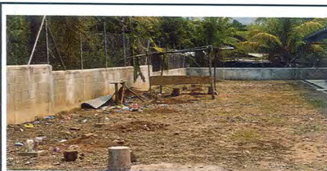
Foto 4: Se puede observar la perforación del área en donde se instalarán las columnas para la base que sostendrá la ampliación del corredor a realizar.
